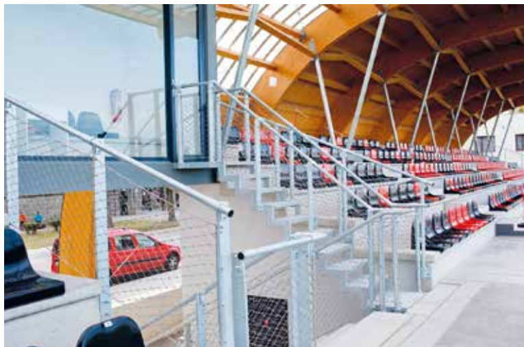
Nerezové sítě X-TEND® jsou vypnuty do obvodového lana.
