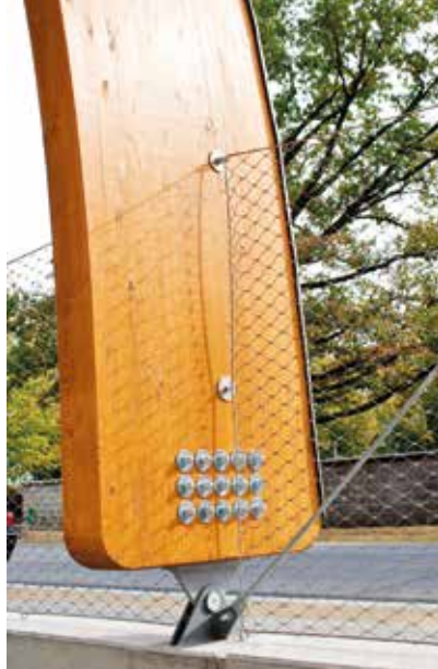
Nerezové sítě X-TEND® jsou vypnuty do obvodového lana.
