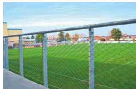
Nerezová síť X-TEND® zde slouží jako bezpečnostní výplň proti pádu osob.
