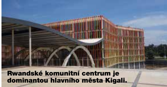
Instalace 1 800 metrů sítě zábradlí v samém srdci Afriky byla pro naše vedoucí montéry výzvou.
